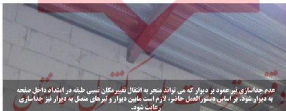
شکل پ-۷-۲ ایراد متداول مربوط به عدم جداسازی مابین تیر و دیوار.
